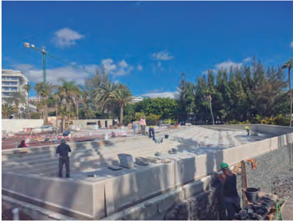
Hotel Meliá Tamarindos (Piscina principal en ejecución)
