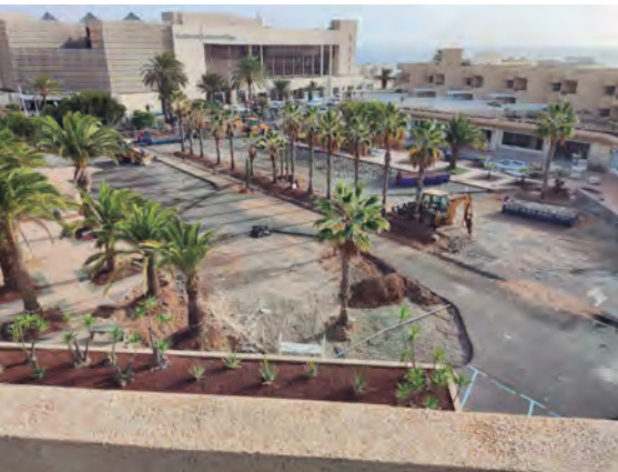
Hotel Lanzarote Mar, Costa Teguisé (En ejecución 2022)
