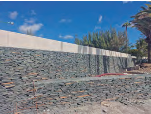
Hotel Meliá Tamarindos (En ejecución - Muros de laja exteriores Piscina Principal 2023)
